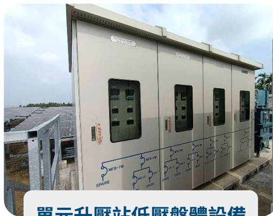
單元升壓站低壓盤體設備
