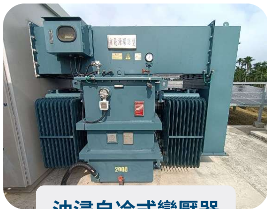
油浸自冷式變壓器
