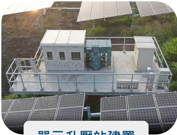
單元升壓站建置
