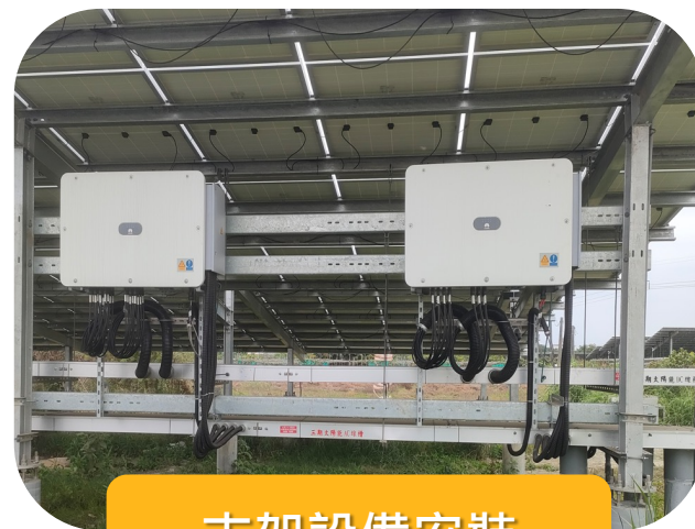
支架設備安裝
