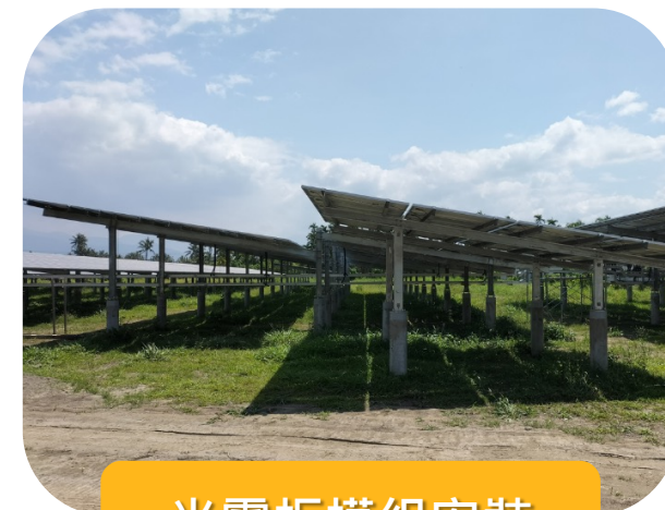
光電板模組安裝
